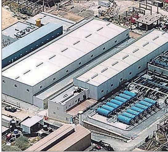
Vista desde arriba de la desaladora de Escombreras (Murcia). EE
