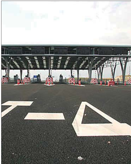
Autopista M-12, en Madrid. EE
